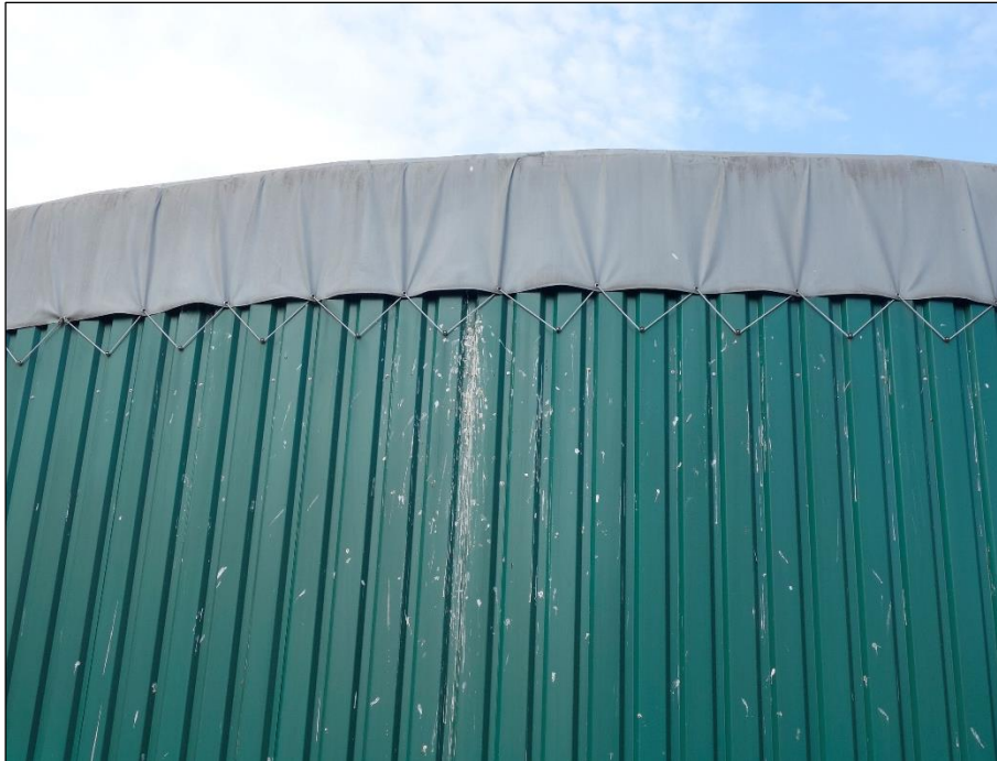
Abb. 9: Am Fermenter könnten zwischen dem Überstand der Außenmembranfolie und dem Stahlmantel für Fledermäuse geeignete Hohlräume vorhanden sein; der Star ( Sturnus vulgaris ) nutzt diese als Brutplatz (07.06.2023).
