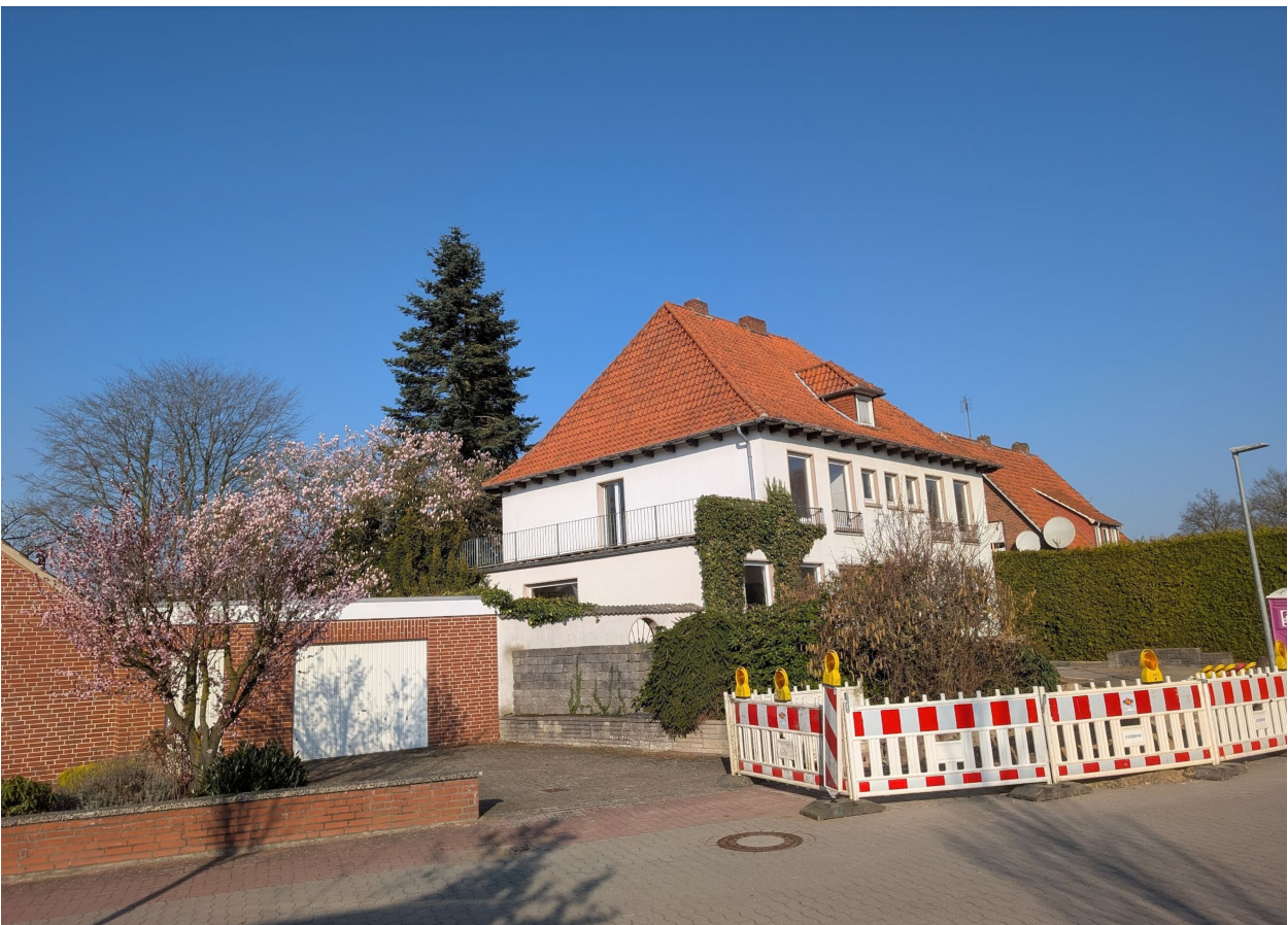
Abb. 3: Mehrfamilienhaus an der Kreuzstraße mit altem Ziegeldach.
