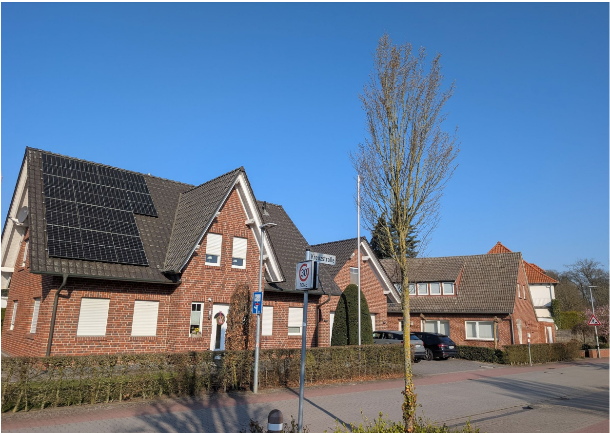
Abb. 4: Neubau an der Ecke Kreuzstraße / Klapphakenstraße.
