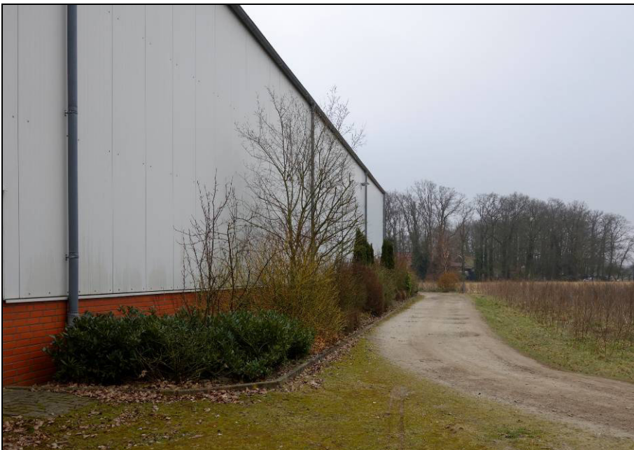
Abbildung 2: Im Westen stehen zwischen der Betriebshalle und dem Rad-/Fußweg einige Ziergehölze (21.03.2018, Verf.).
