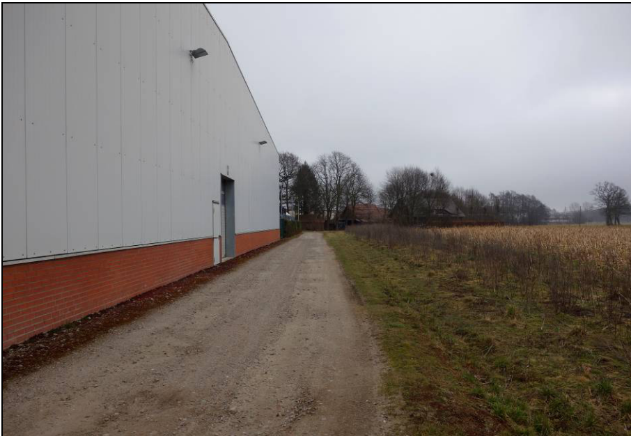
Abbildung 1: Auf der Südseite des Betriebsgeländes verläuft ein Rad-/Fußweg; an diesen grenzt eine Ackerfläche, die in dem zu überplanenden Bereich teilweise als Ackerbrache vorliegt (21.03.2018, Verf.).
