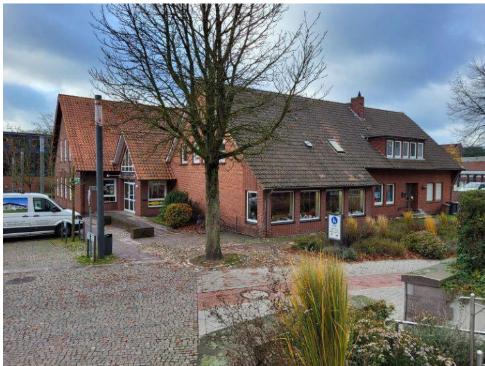
Foto 1: Blick von Nordosten auf den Gebäudekomplex
