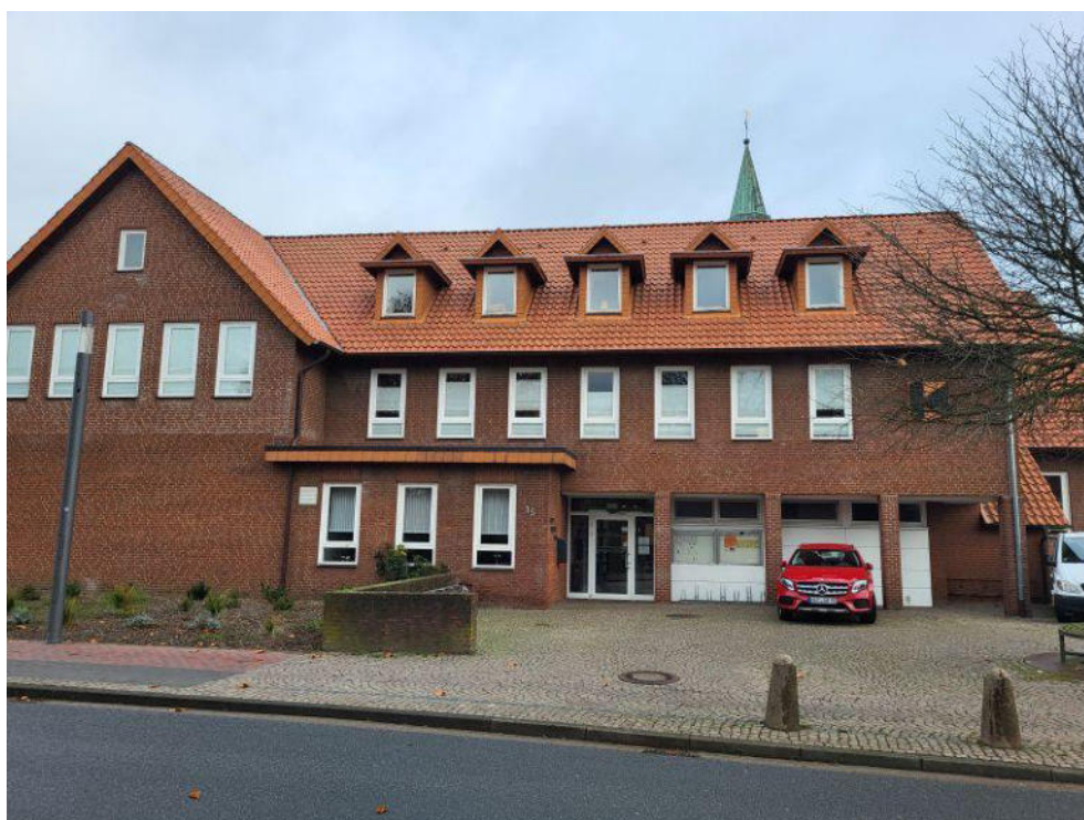
Foto 2: Blick von Süden auf den Gebäudekomplex
